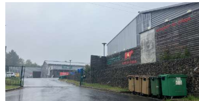
Bâtiments d'activités (jardinerie)
