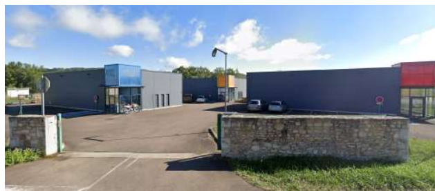
Bâtiment d'activités dans le PA La Perrière
