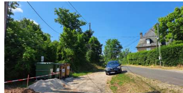
Dilatation de la RD33, au Nord-Est du site
