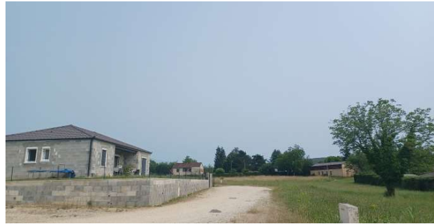
Nouveau lotissement en construction
