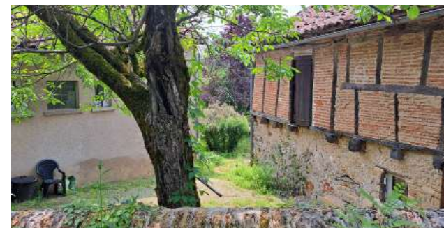
Bâti ancien au Nord-Est
