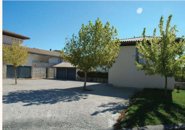
Plantation d'arbres pour 6 logements intermédiaires - GGR Architectes - Montratier (46)
