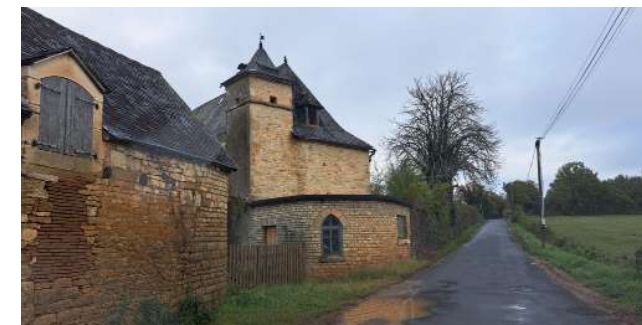
Corps de ferme avec tour pigeonier remarquable au Nord
