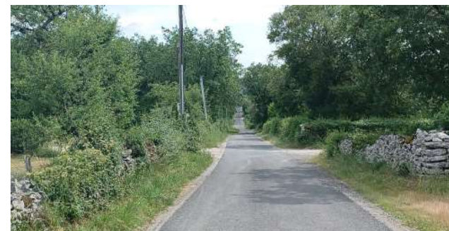
Voie reliant la RD840 à la route des Vignes du Causse
