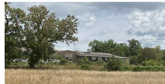
Vue sur la menuiserie depuis le site 3
