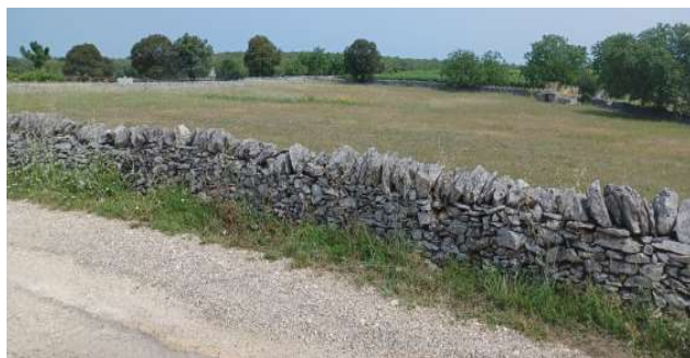
Muret en pierre sèche
