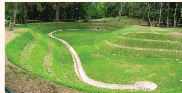
Création d'un bassin de rétention des eaux pluviales - Comptoir des projets -Essonne (91)
