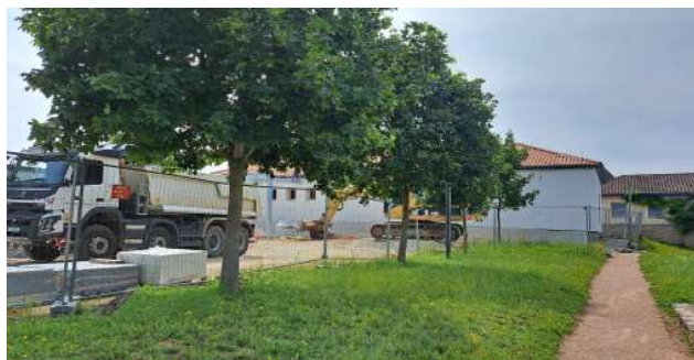
Groupe scolaire en travaux
