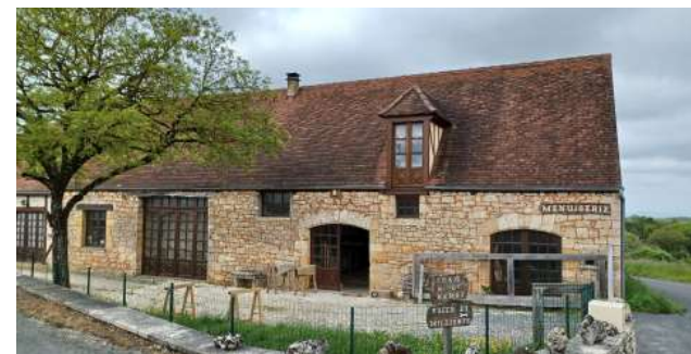
Menuiserie à l'Ouest du site
