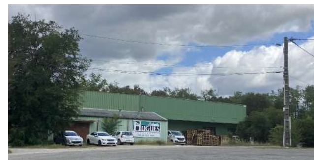
Bâtiment d'activités de la ZA (transports)
