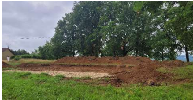
Terrassement pour fondations de nouvelles habitations
