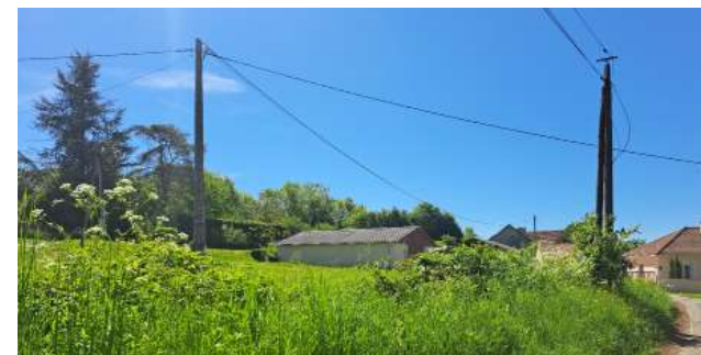
Talus important en limite Ouest
