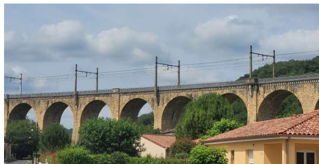
Viaduc de Bramefond
