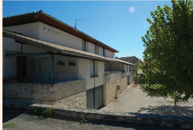
6 logements intermédiaires - GGR Architectes - Montrastier (46)
