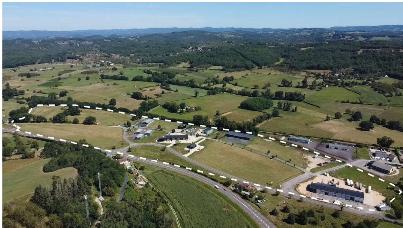
Vue par drone du site
