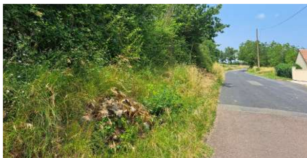
Muret en pierre sèche dissimulé sous la végétation
