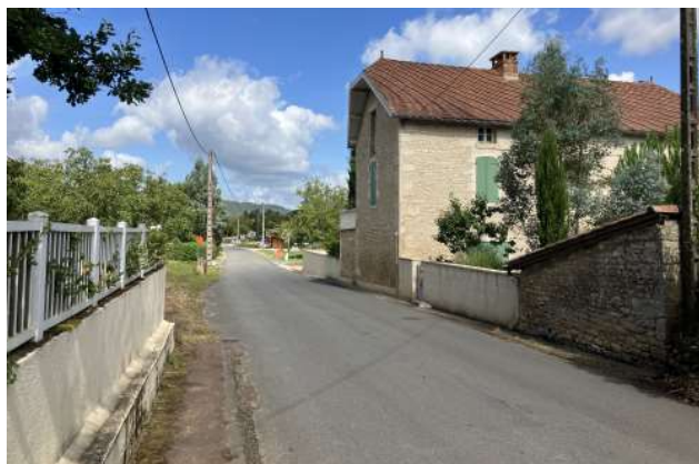
Bâti traditionnel implanté le long de la RD43
