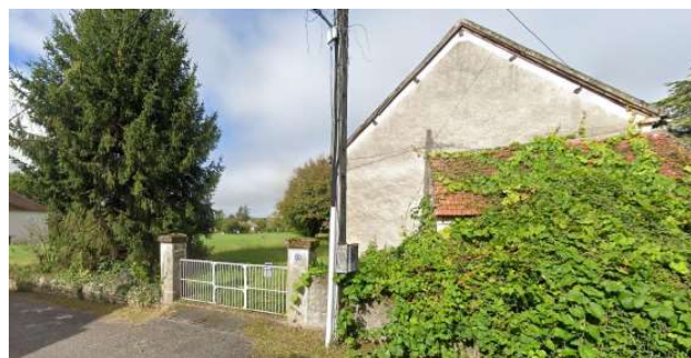
Pignon du bâti, accès depuis l'avenue et arbre résineux
