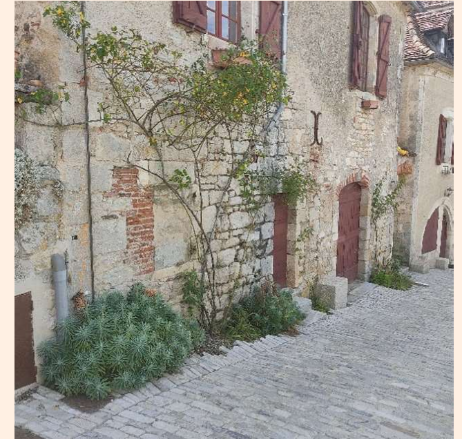
Traitement d'un pied de façade à Saint-Cirq Lapopie (46)
