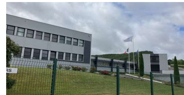
Entreprise industrielle implantée au Sud
