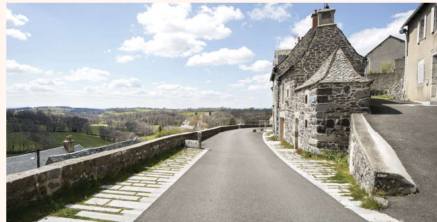
Requalification des cheminements piétons - Coco Architecture - la Motrice - Camille Fréchou - Laguiole (12)
