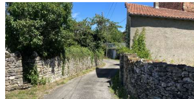
Muret en pierre sèche le long du chemin des Espénières
