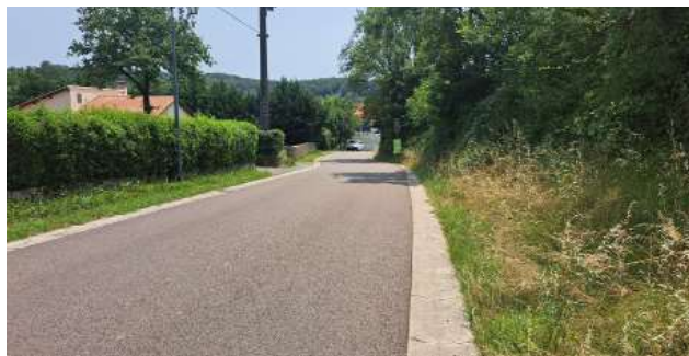
RD20 (site sur la droite)
