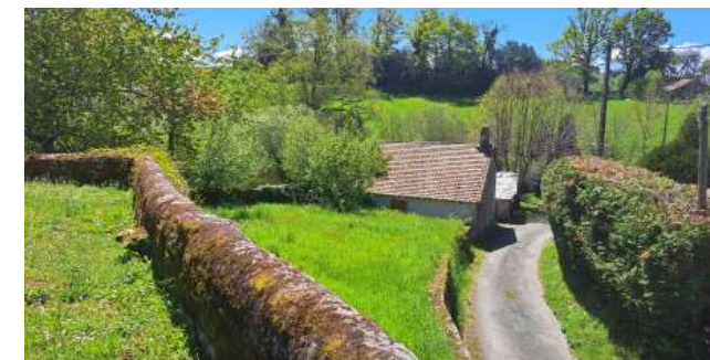
Muret en pierre maçonné devenant mur de soutènement et formant un belvédère
