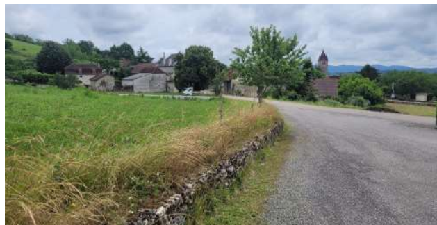
Muret en pierres sèches
