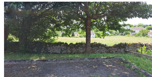
Muret en pierres sèches bordant le site
