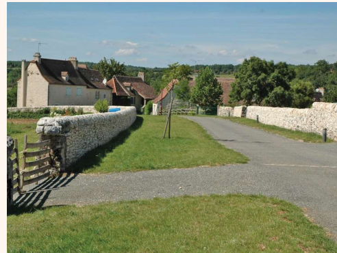
Alignement marqué par un muret en pierre sèche et bande enherbée plantée mettant à distance la voie - C. Broichot - G. Laizé - Le Bastit (46)
