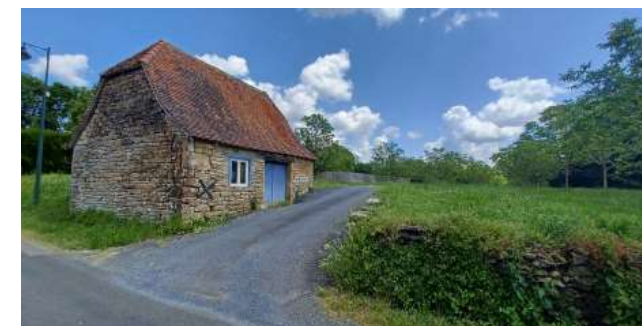
Bâti remarquable au Sud-Est
