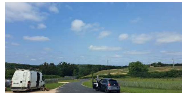
Accès créé pour l'éco-barri
