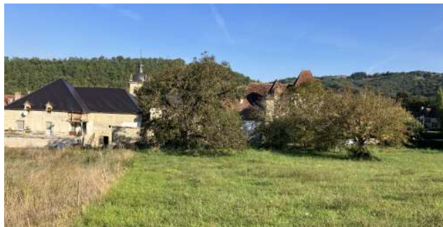
Vue du site depuis le Nord
