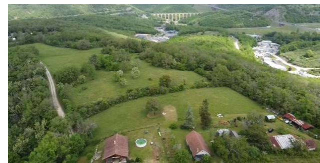
Vue drone du site depuis le Sud
