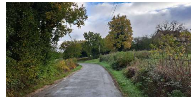
RD33 et arbre remarquable au Nord
